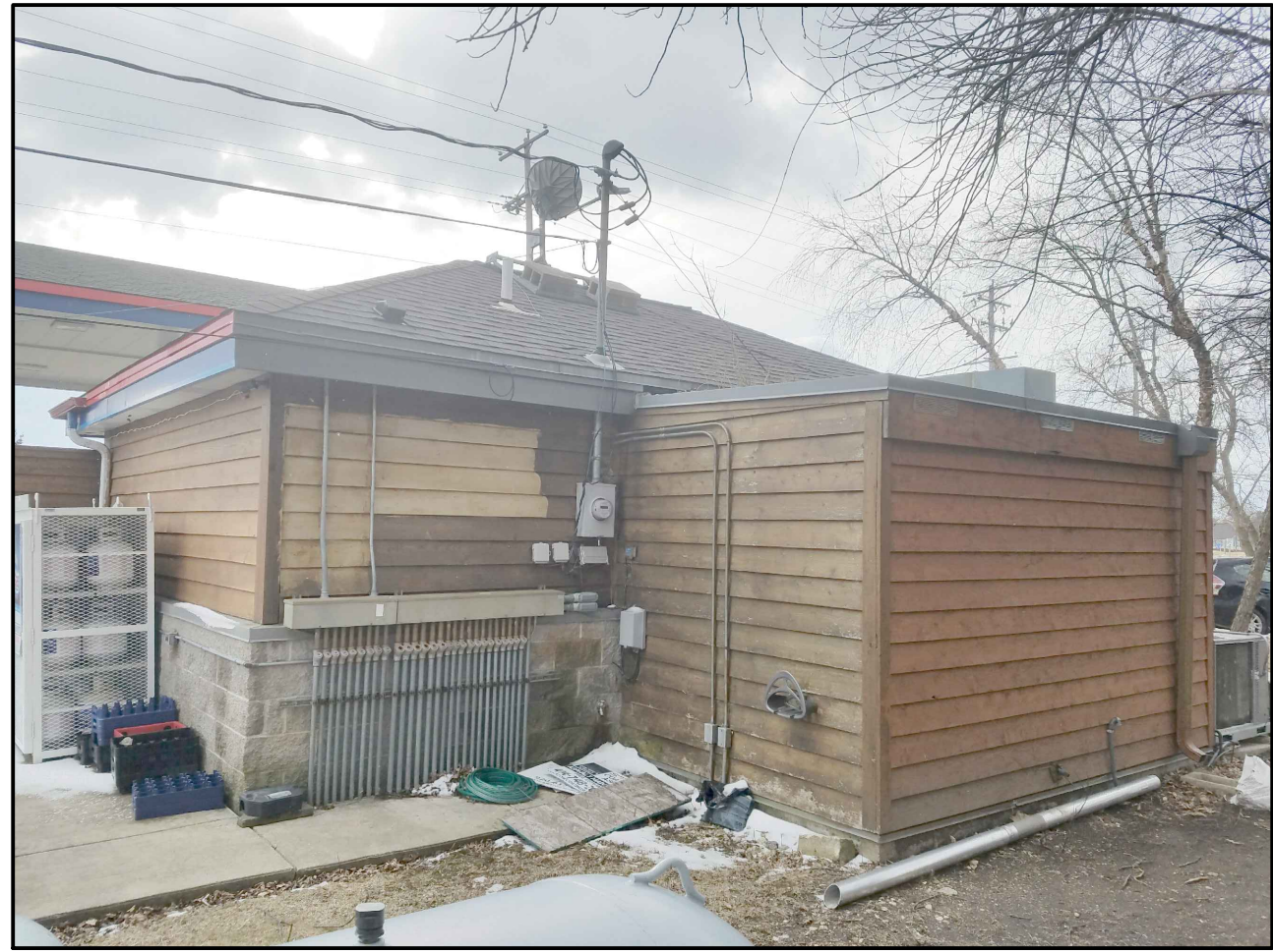
9 EXISTING WEST PHOTO N.T.S.
