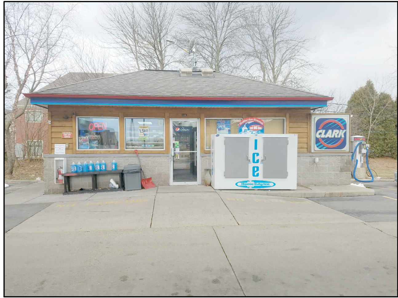
6 EXISTING EAST PHOTO N.T.S.
